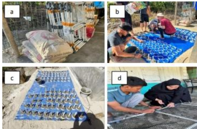
Proses pembuatan meja transplantasi dan pemberat: a). Alat dan bahan yang digunakan, b). Pembuatan pemberat meja transplantasi, c). proses pengeringan pemberat, d). Pembuatan substrat transplantasi terumbu karang
