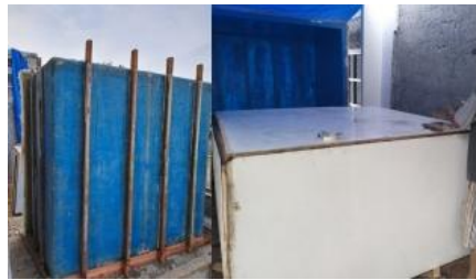
Progres Pengerjaan Instalasi Pengolahan Air
